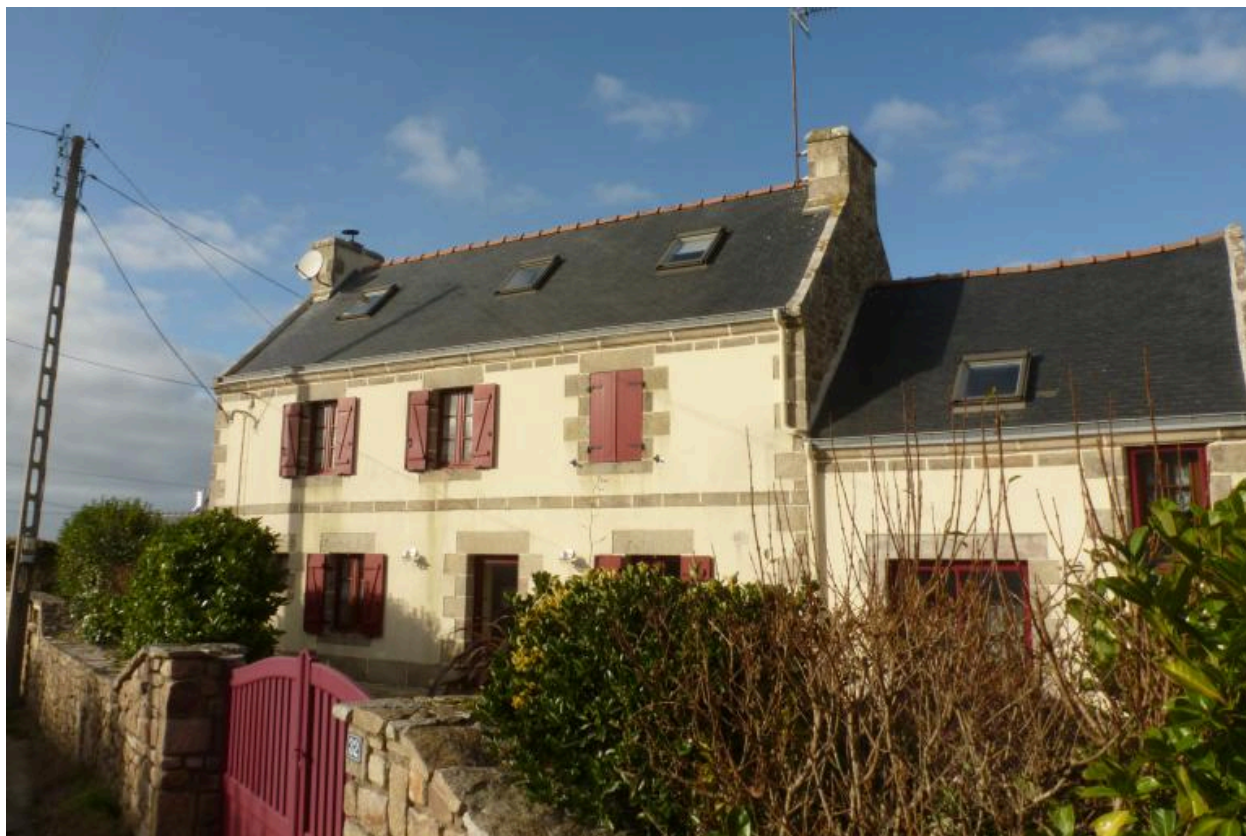
Maison 13, élévation antérieure du logis et de la crèche accolée.
