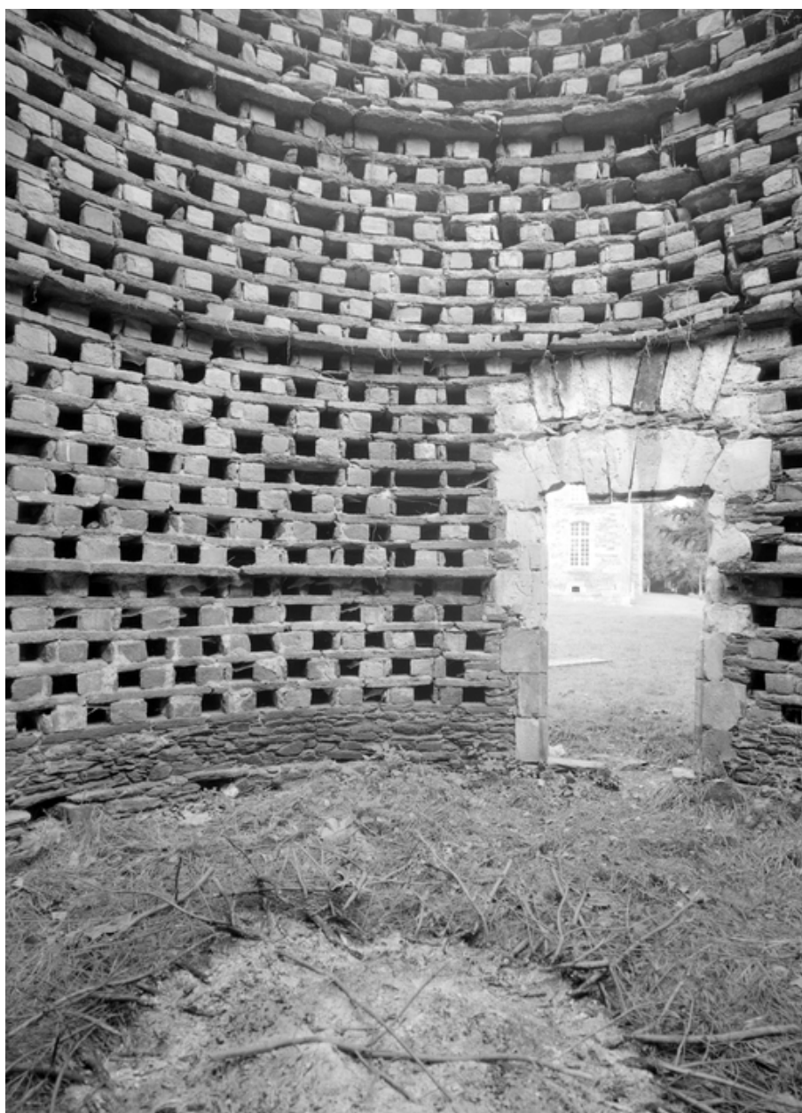
Le colombier, vue intérieure.
