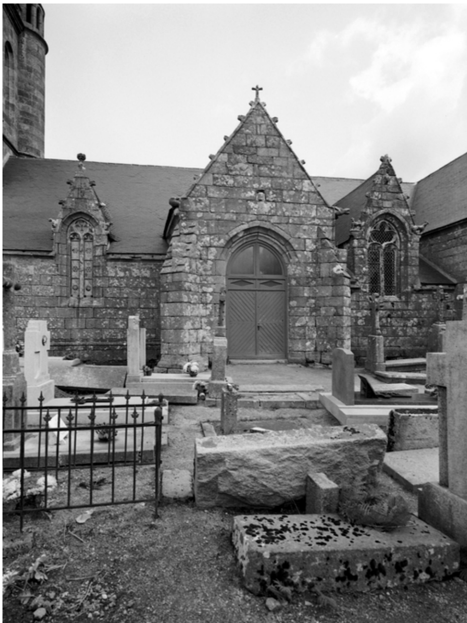
Pignon du porche sud
