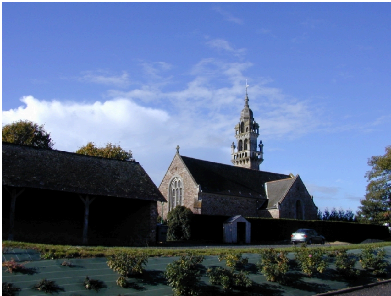
Vue de situation de l'église
