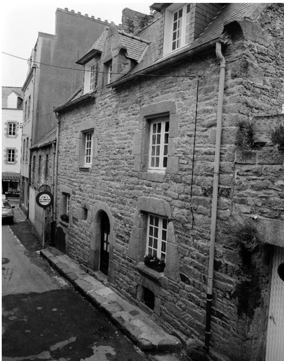
3 rue Yan d'Argent, élévation ouest, vue générale
