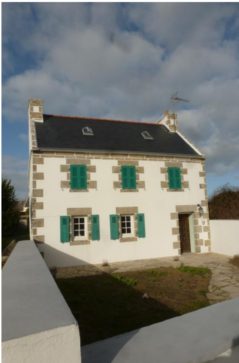
Maison 10, élévation antérieure du logis.
