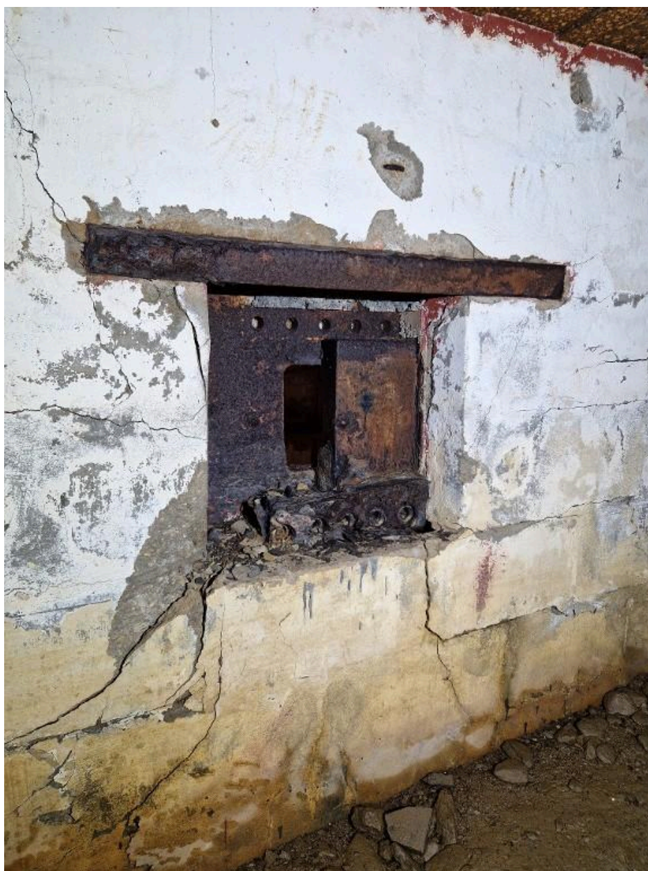
Vue intérieure : créneau blindé de la salle de garde ouest
