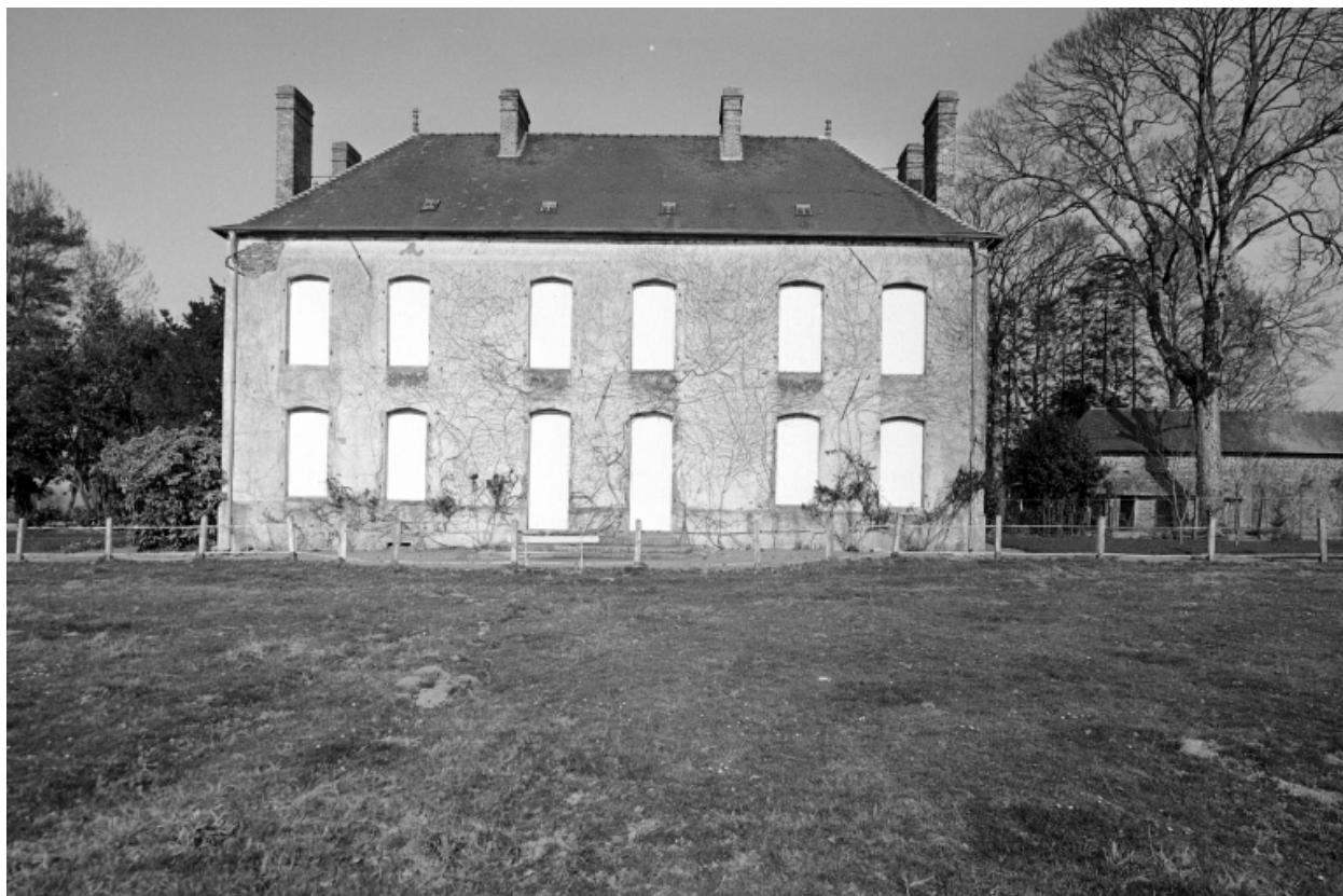
Façade sud-ouest, vue générale.
