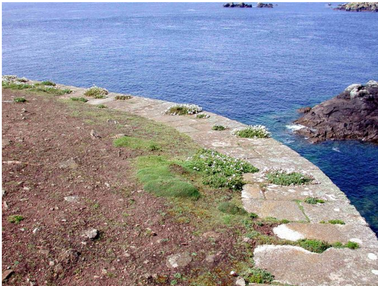
Vue du parapet de la batterie de la Théroute
