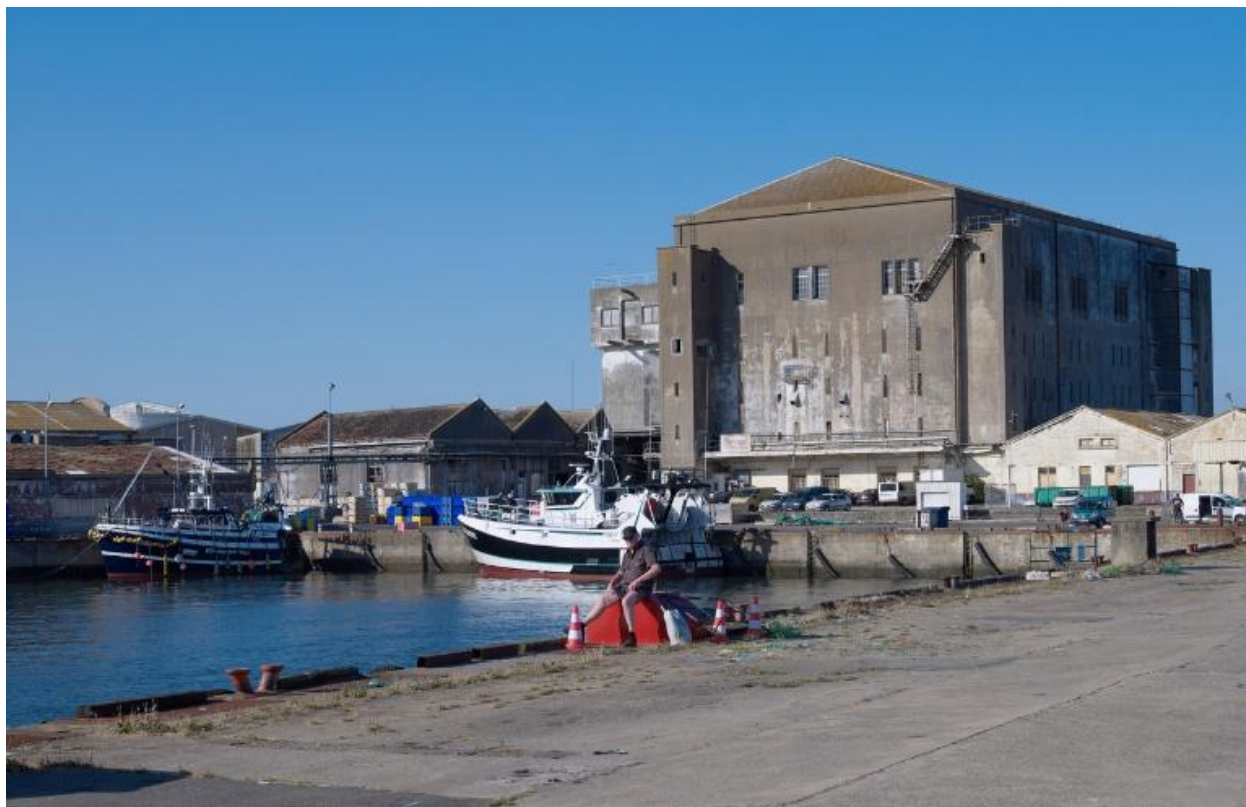
Frigorifique de Keroman, vue générale
