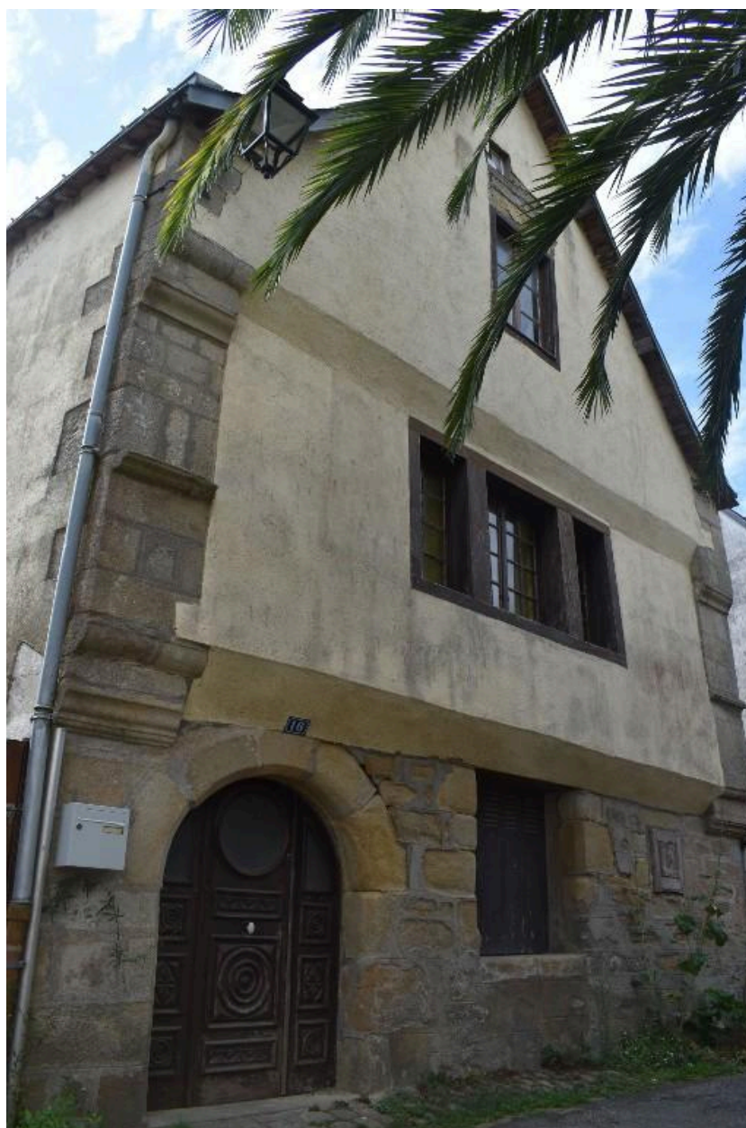
Façade en pan de bois caché avec encorbellement sur solives
