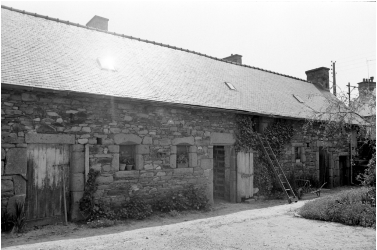
Dépendance, façade antérieure (cliché S. Laffiché, pré-inventaire, 1973)
