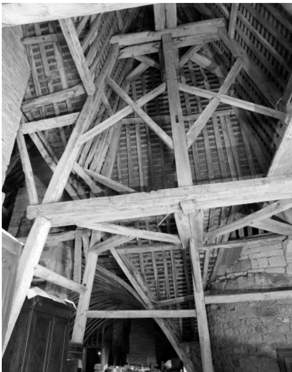
Charpente du pavillon est, vue générale.
