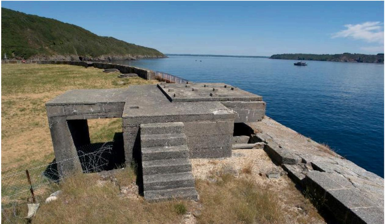
Plouzané : vue du fort du Mengant, détail de la batterie basse, parapet et poste de combat en béton armé (vraisemblablement allemand)
