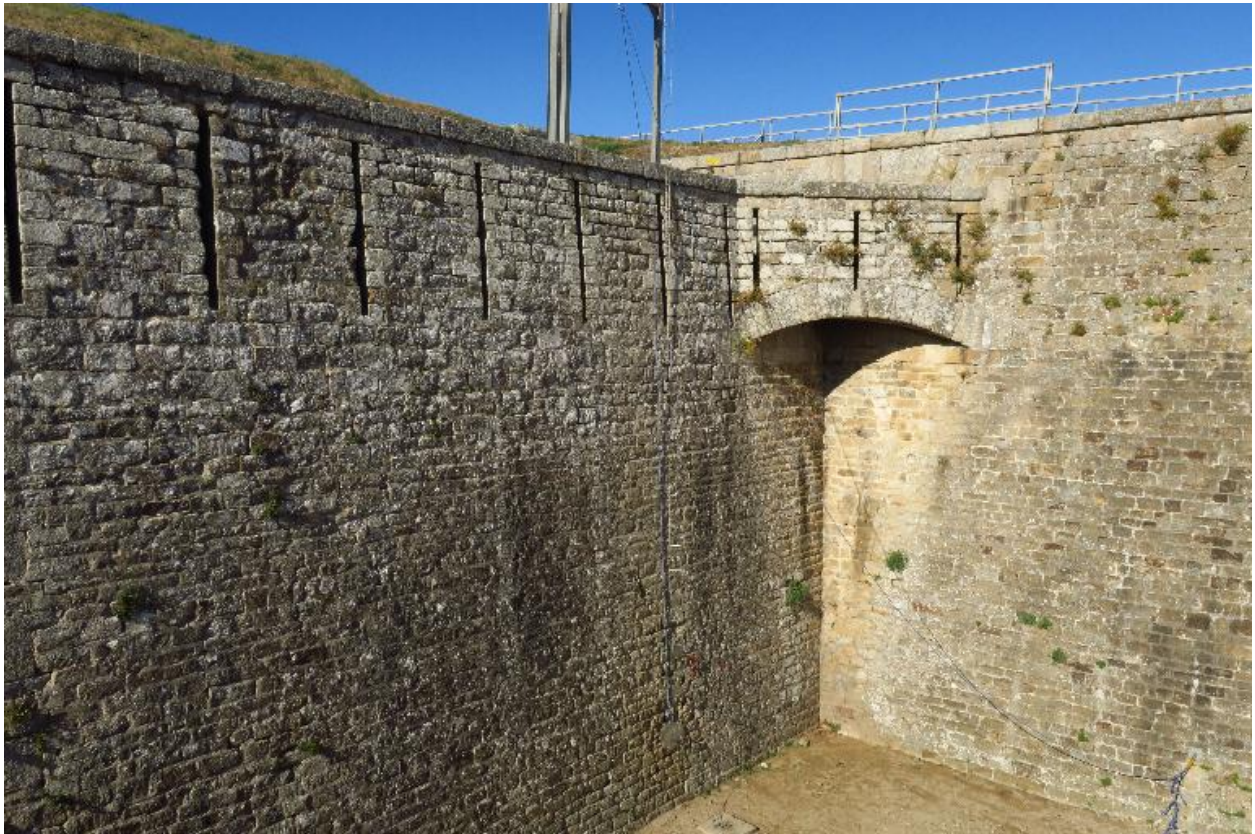
Saint-Pierre-Quiberon, fort de Penthievre, enceinte, parapet crénelé et créneau de pied de la jonction entre la branche nord-est et le redan.
