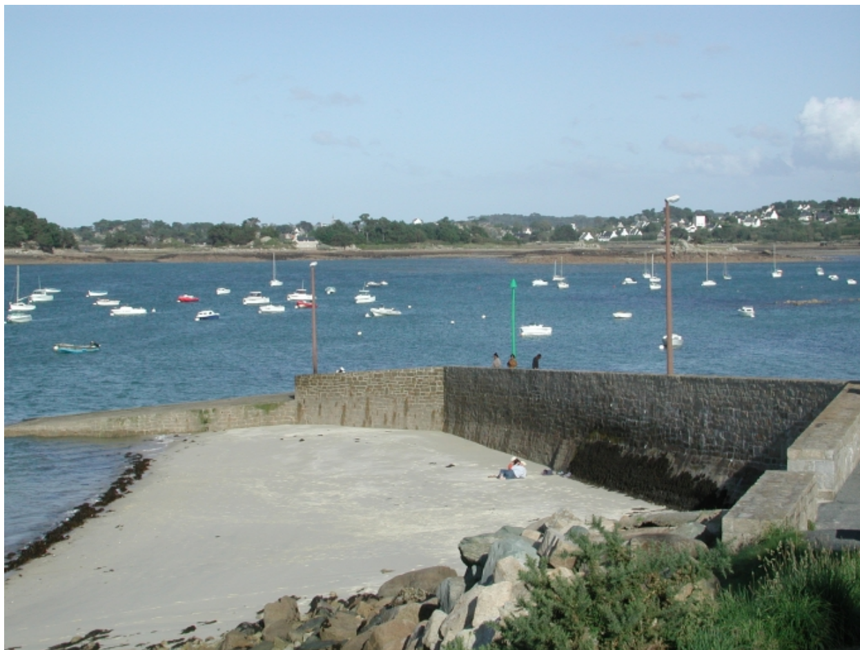
Vue du mur de la jetée débarcadère à l'Ouest et de la cale dans le prolongement
