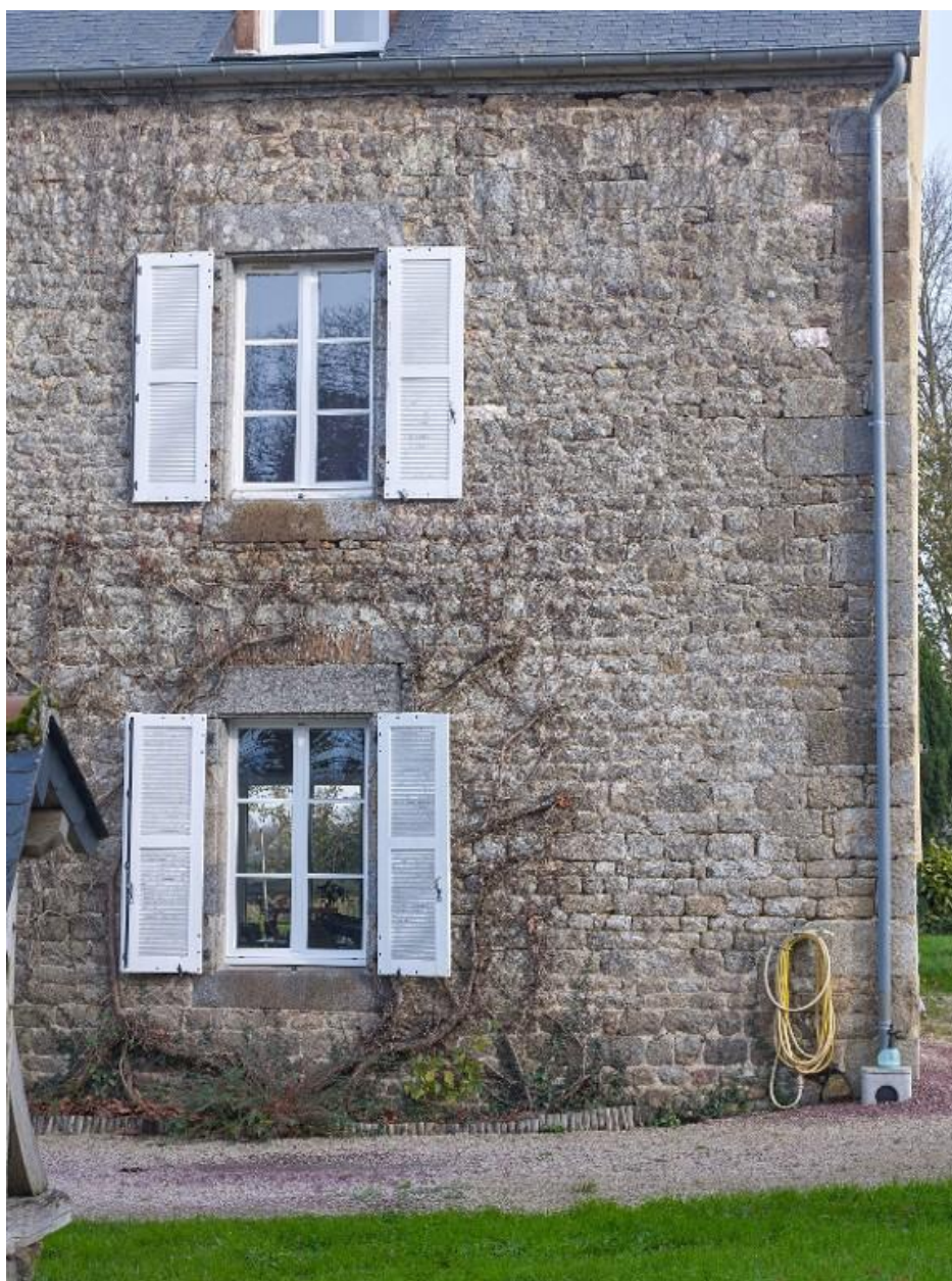
Façade ouest. Travée de fenêtres
