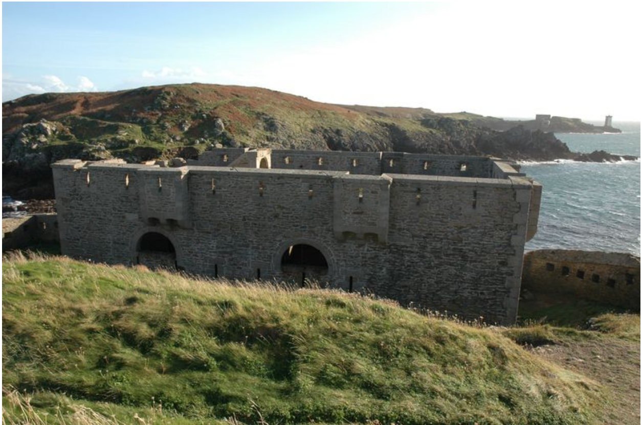
Vue du réduit de l'Îlette depuis la batterie haute
