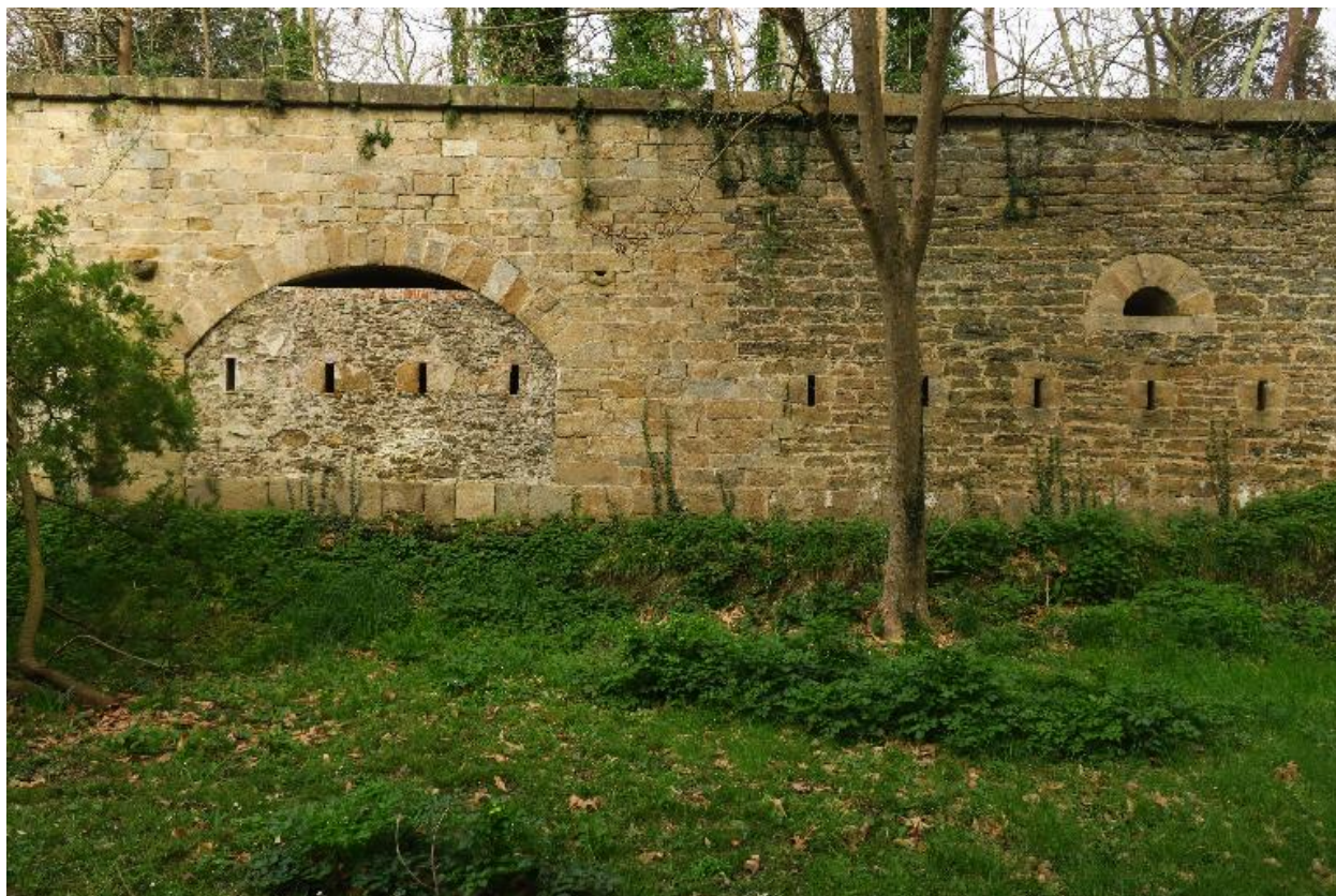
Le Palais, enceinte urbaine, galerie de contrescarpe, extrémité droite, jonction entre les deux galeries.
