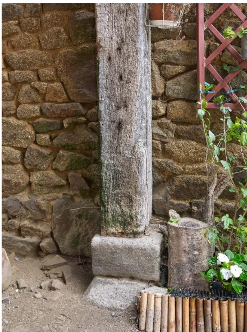
Détail du poteau reposant sur un dé de pierre pour bloquer les remontées d'humidité.
