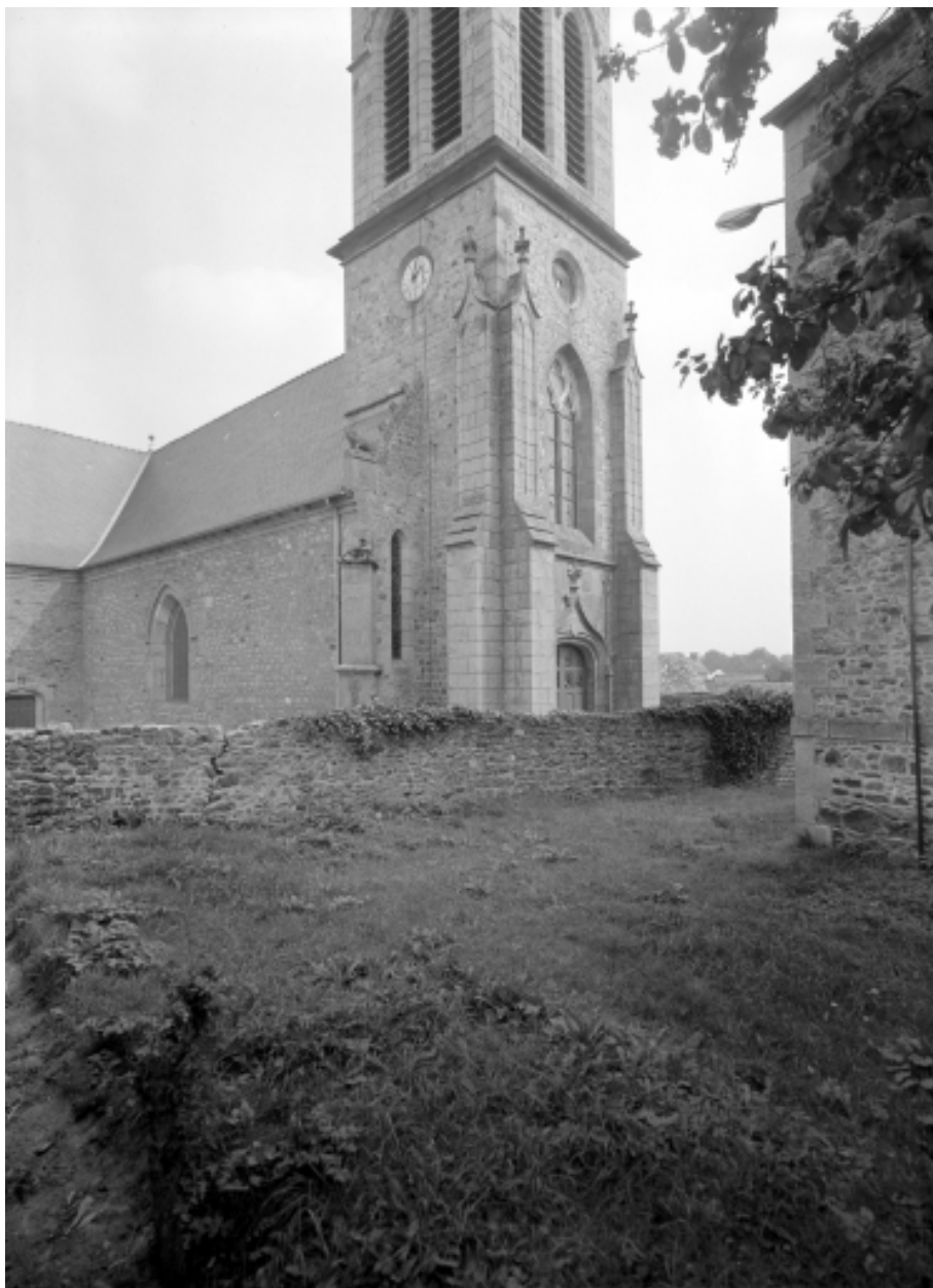
Elévation nord-ouest : vue générale
