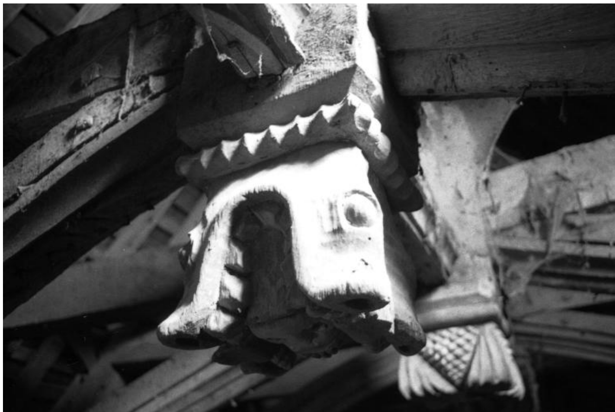
Charpente, détail de la clé 18.
