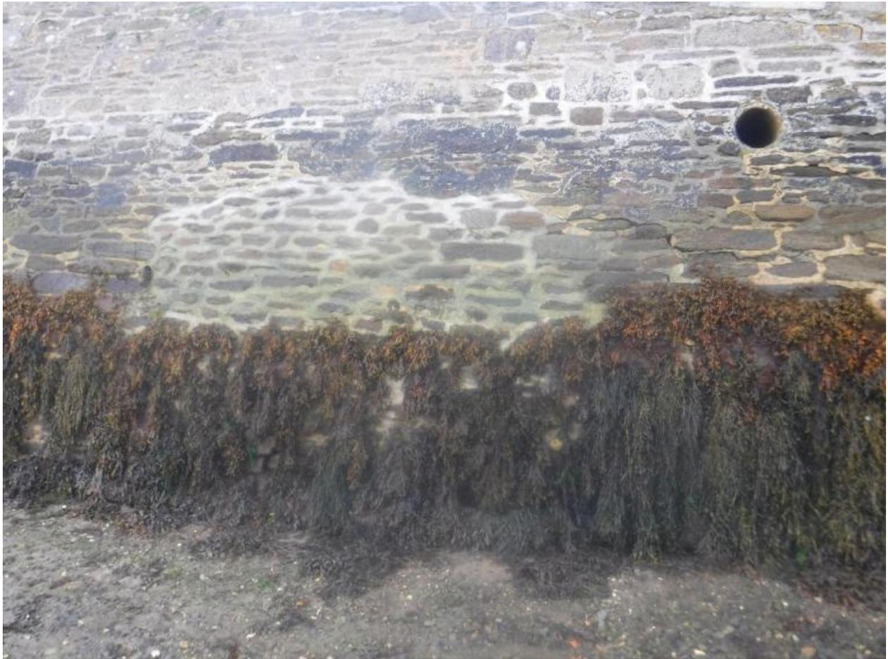
Reprise de maçonnerie suite à un effondrement en 2013 (photo de 2018). L'effondrement du 28 octobre 2023 est au même endroit.
