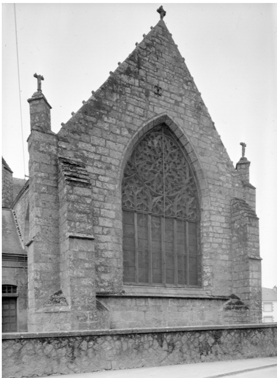
Mur est du chevet.
