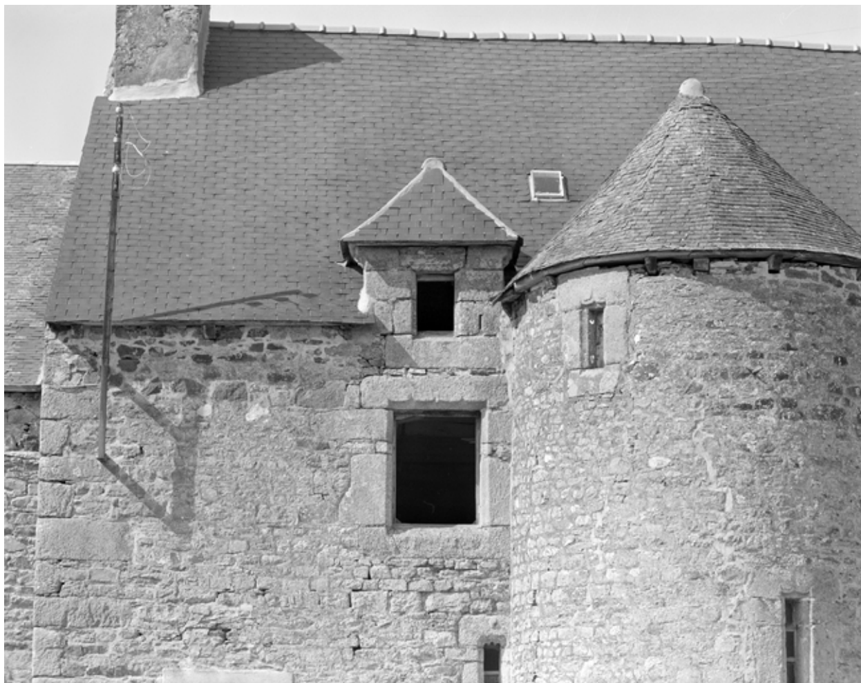
Premier étage : lucarne et fenêtre à l'ouest de la tourelle
