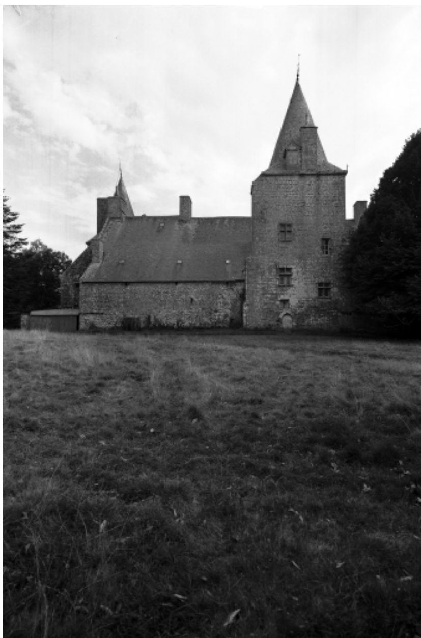
Façade nord : vue générale
