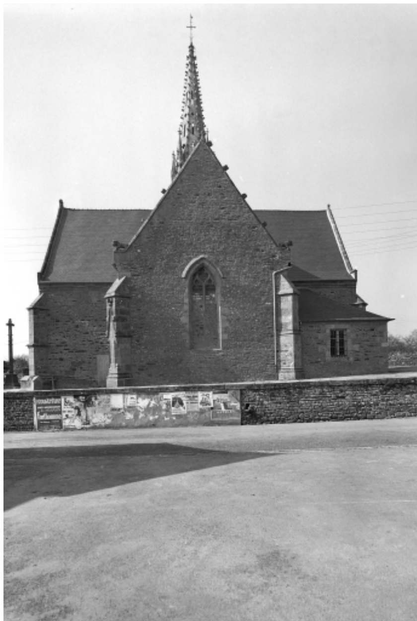
Façade est, vue générale.
