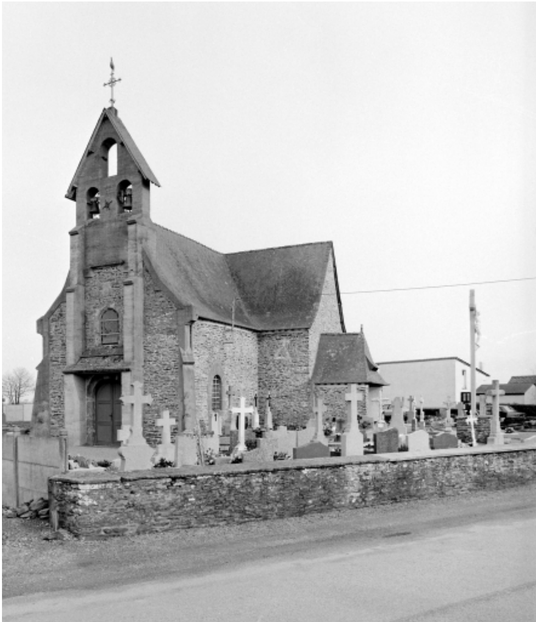
Elévation Sud-Ouest : vue générale
