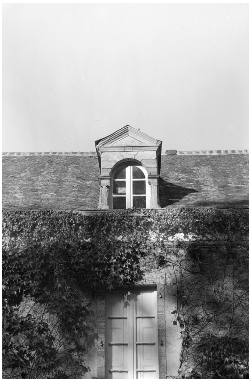
Façade sud, vue de détail d'une lucarne.
