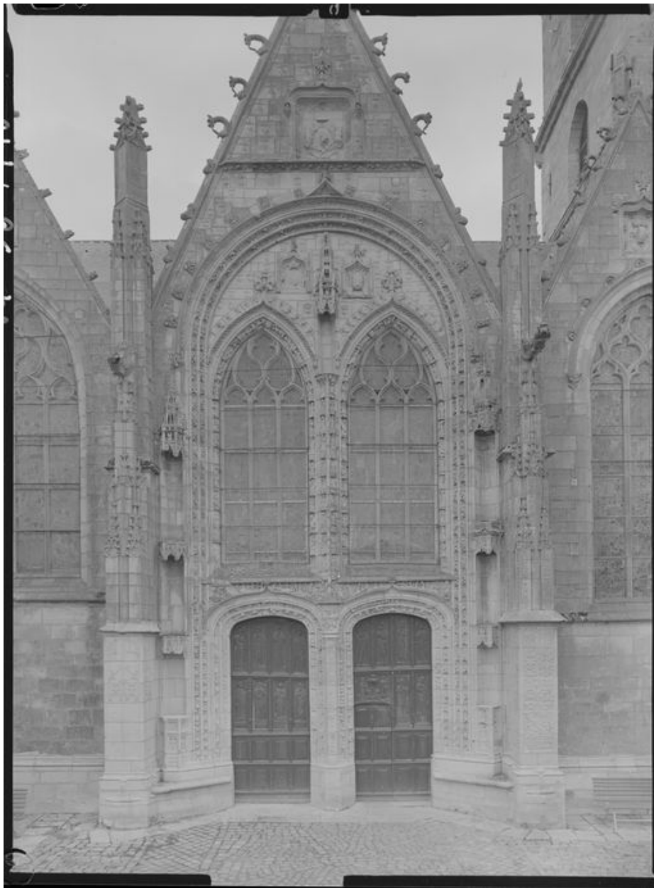
Porche nord vue générale
