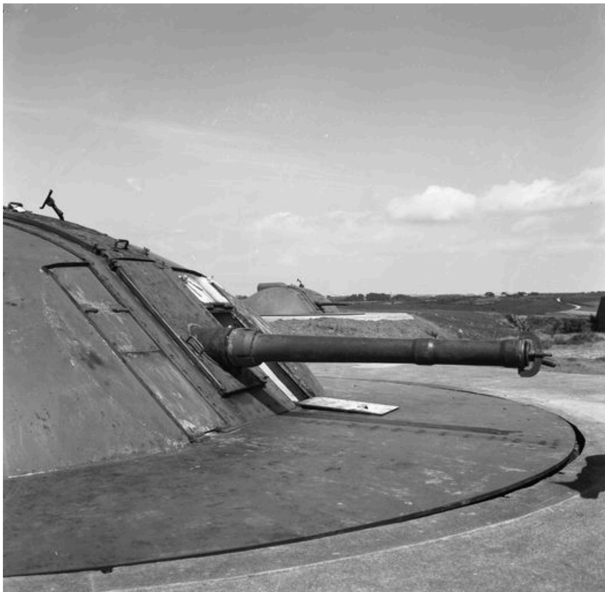
Vue de l'un des quatre canons antiaériens de 10,5 cm sous blindage (état en 1969). Le blindage est de type en calotte sphérique
