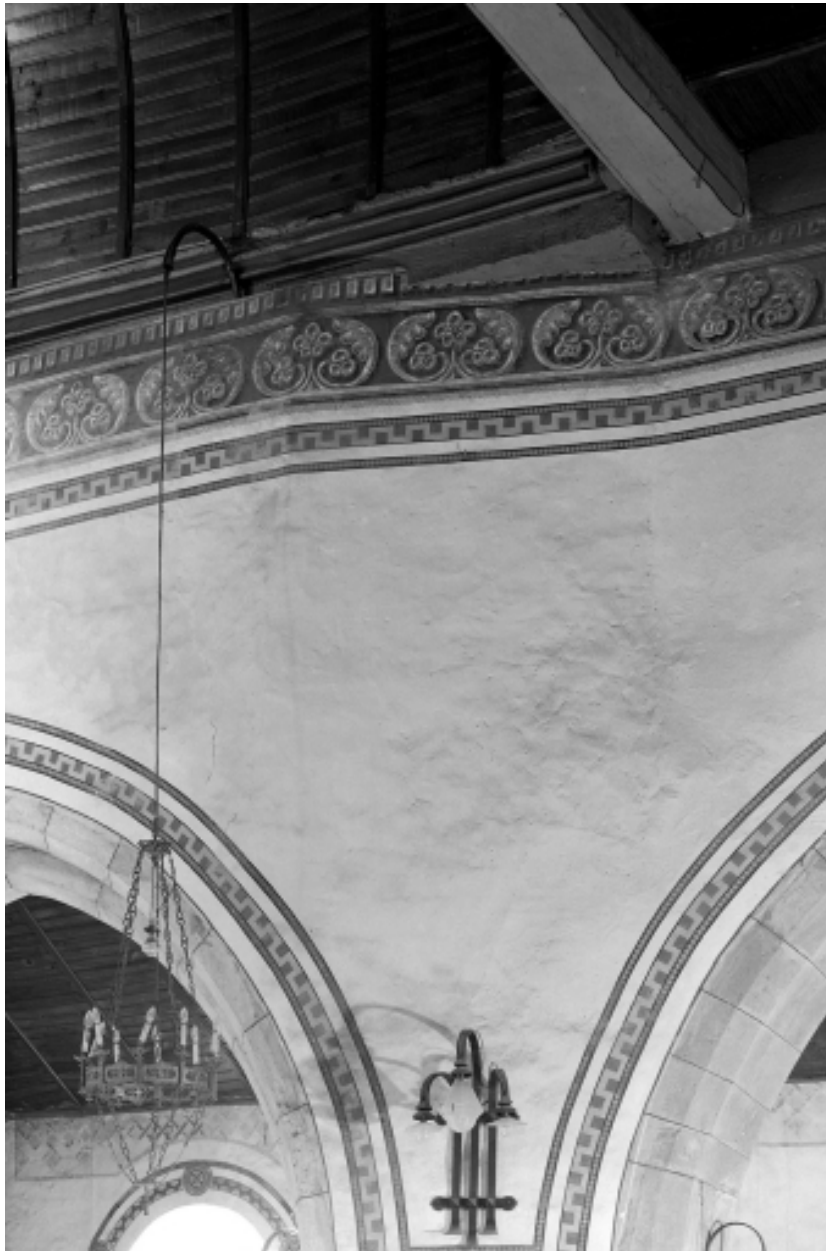
Nef, face sud, écoinçon 4è et 5è arcades.
