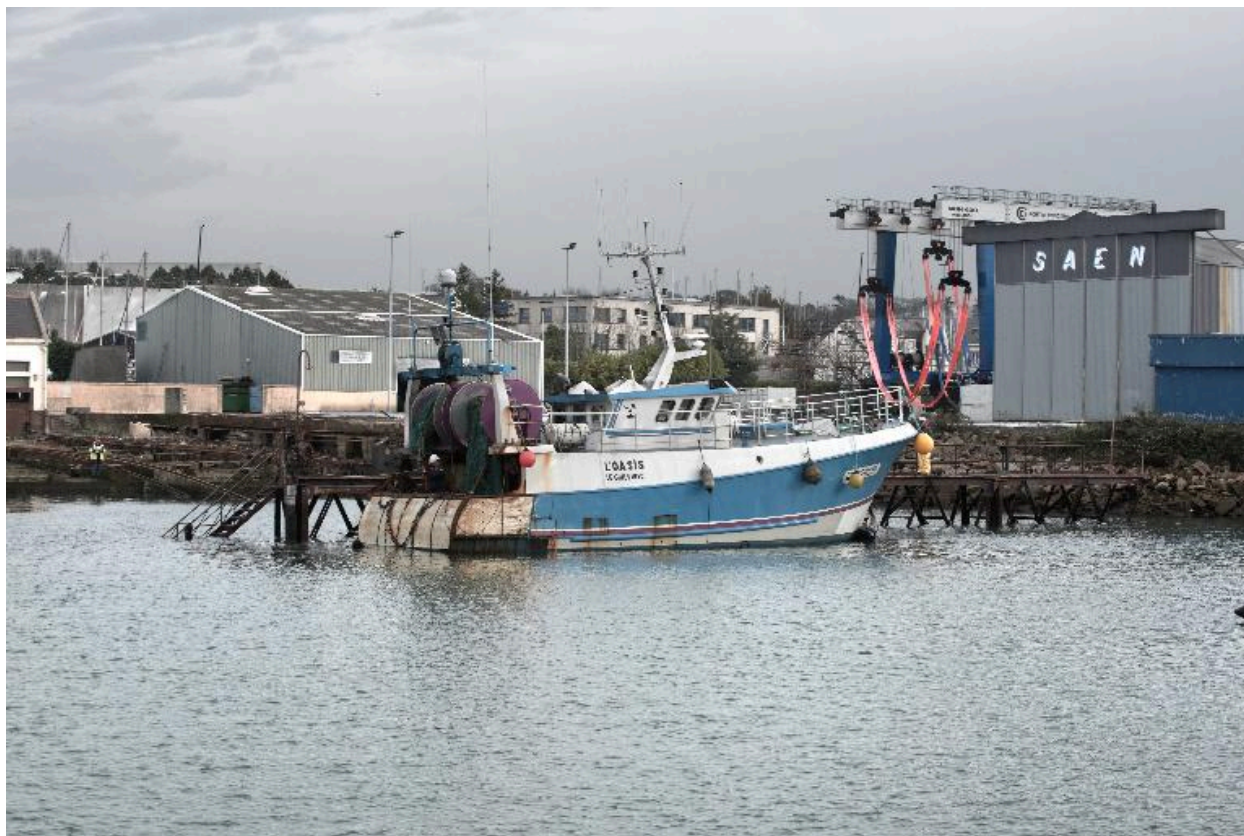
Zone portuaire, vue générale
