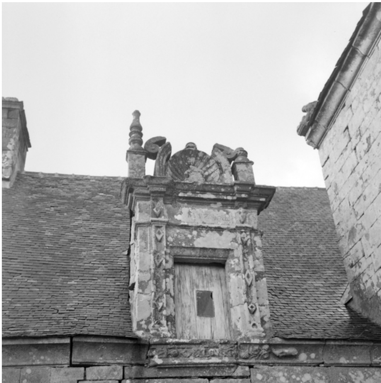
Lucarne de la façade est du bâtiment secondaire à l'ouest B.
