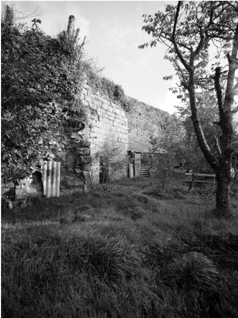
Vue sud-ouest de la tour
