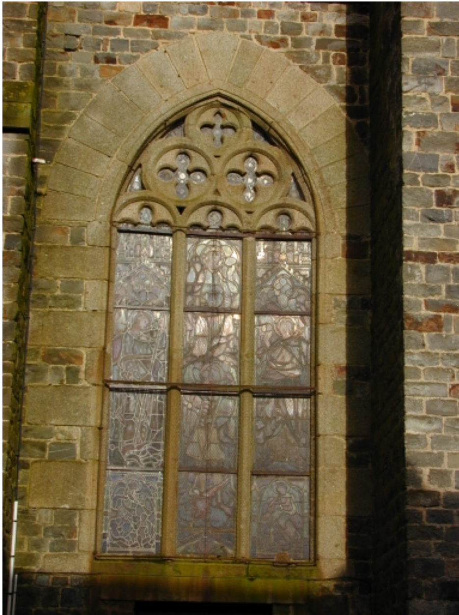
Détail : façade sud, baie provenant de l'ancienne église
