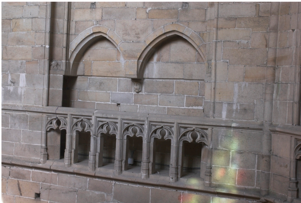
Vue du triforium du choeur
