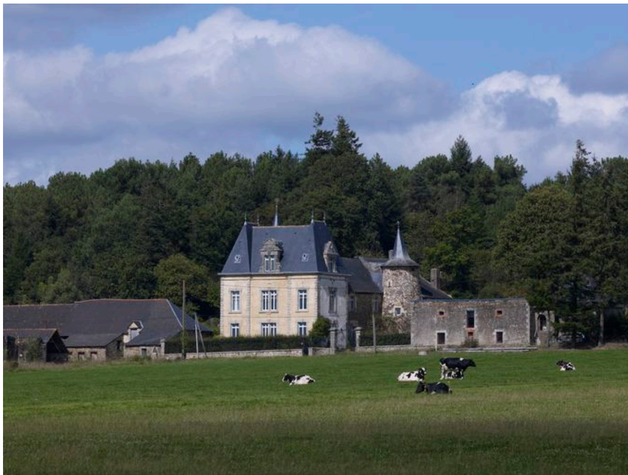
Vue générale prise du sud
