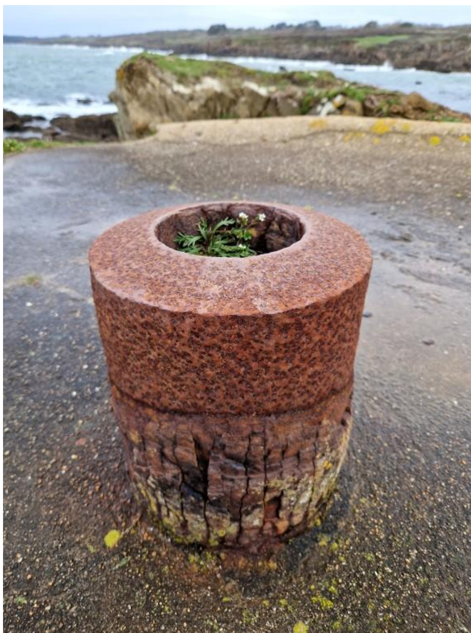
Vue du conduit du périscopes émergeant de la dalle de couverture
