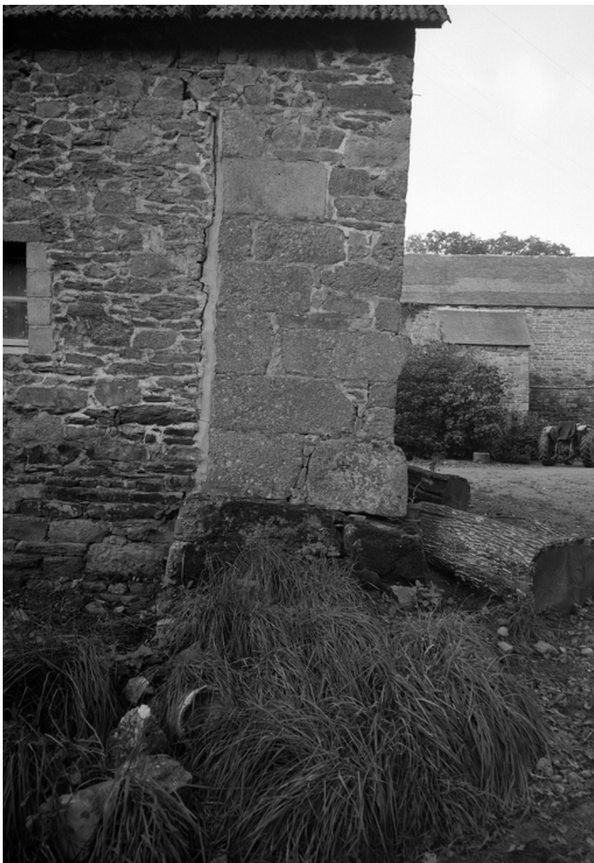
Porcherie : face est - angle nord-est : détail du piédroit d'un ancien portail
