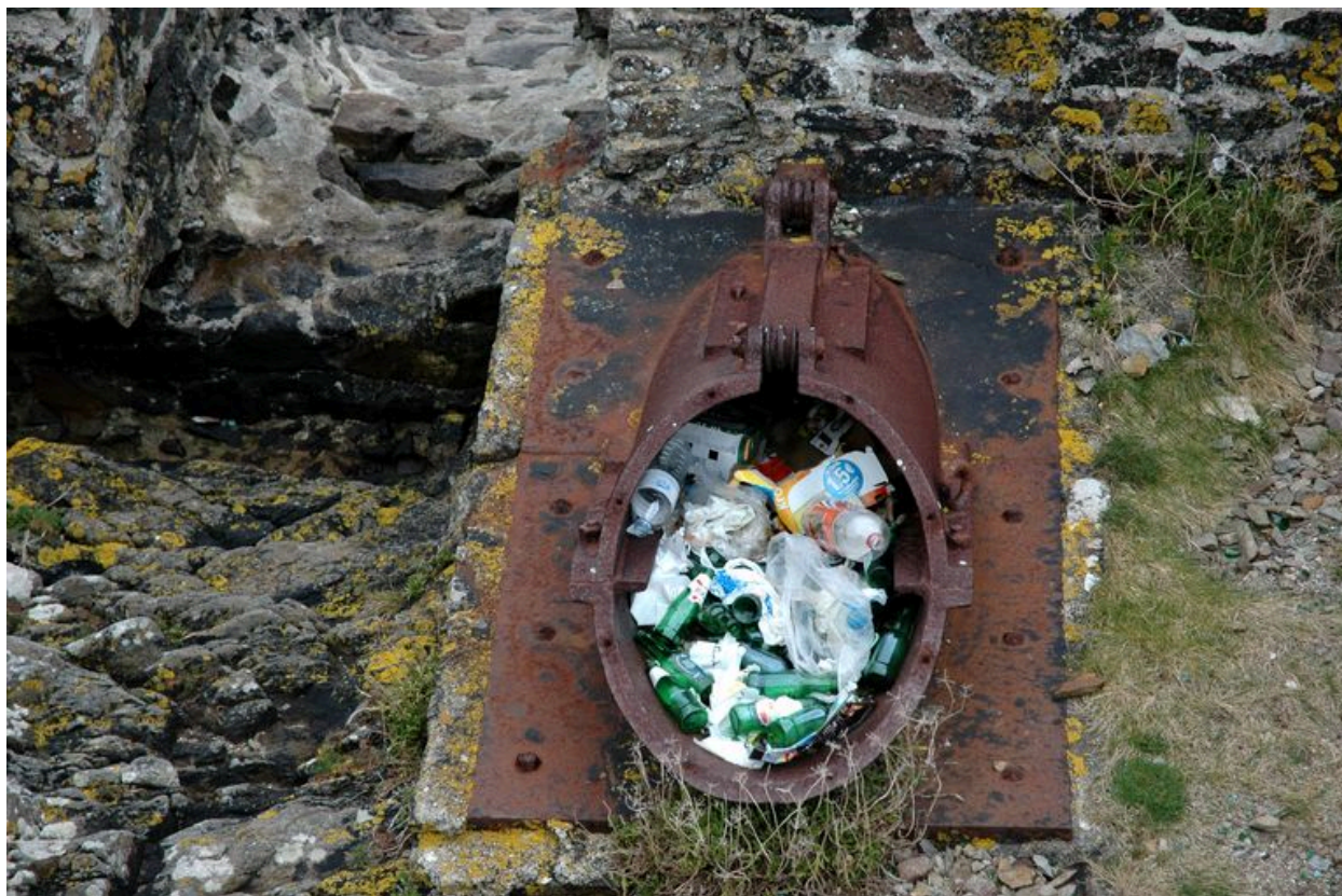
Vue du tube de lancement (état en 2006)
