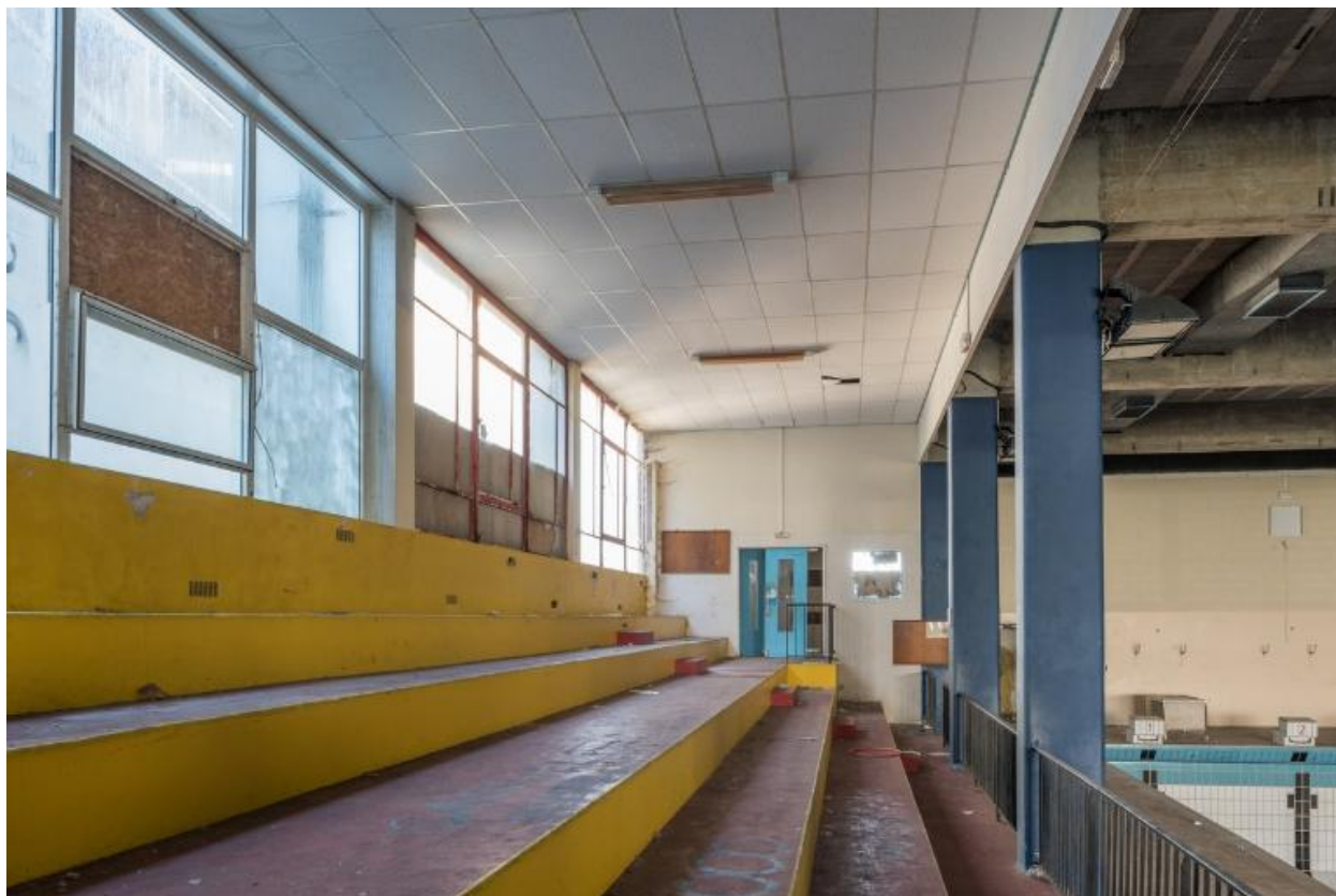
Vue d'ensemble des tribunes de la piscine. Jean de Jaegher et François Rousseau, architectes, 1968.
