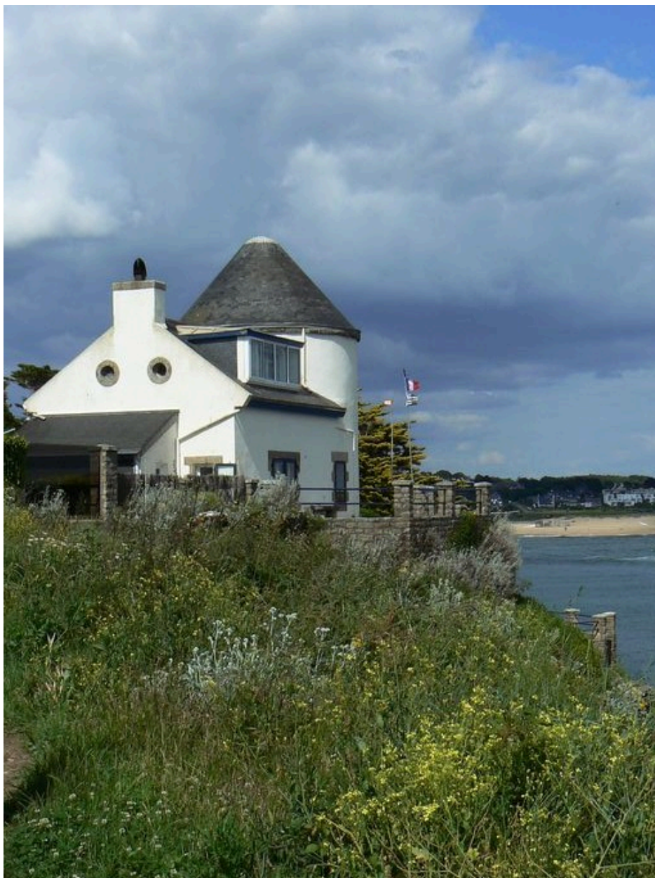
Vue générale du mât pilote
