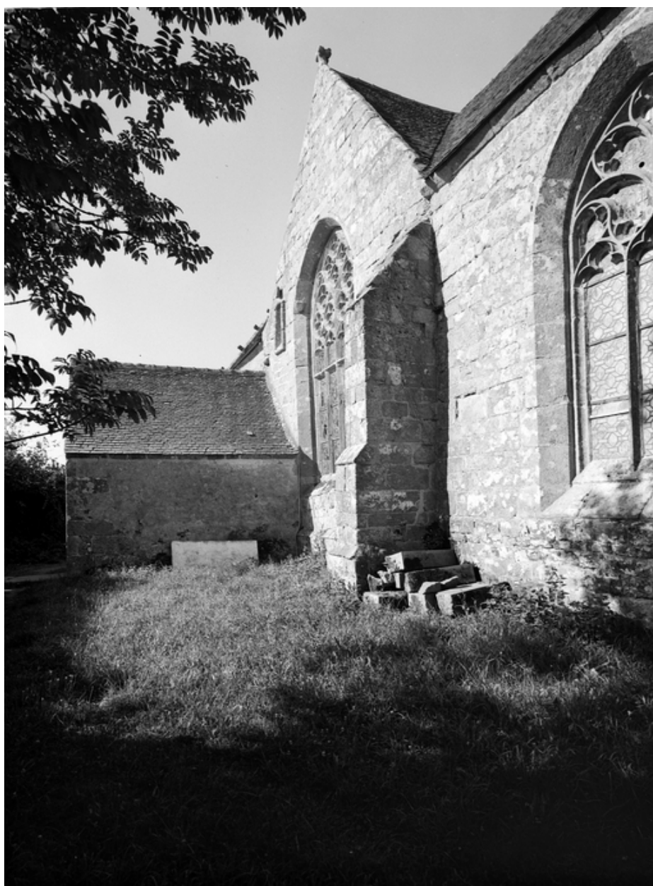
Façade est : mur pignon de la partie centrale
