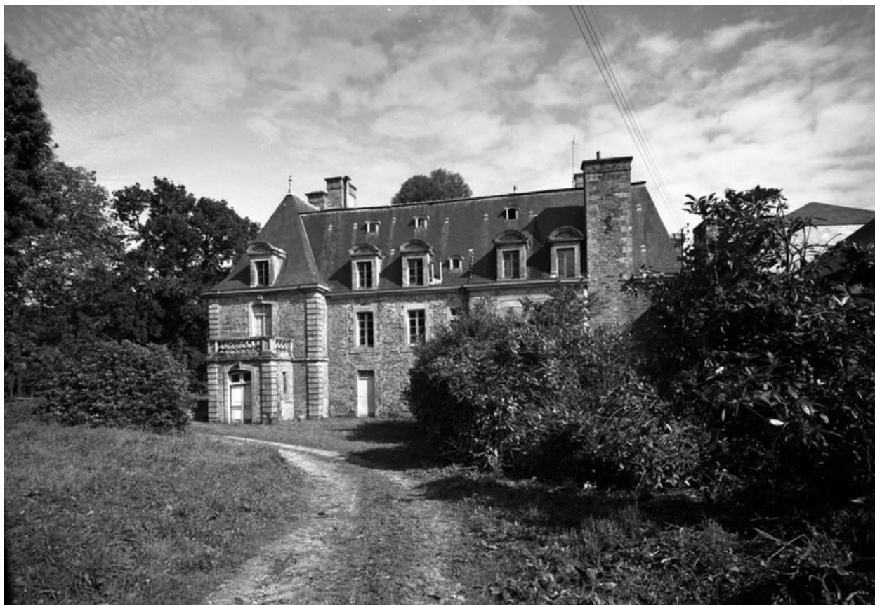
Vue générale nord-ouest : état en 1986
