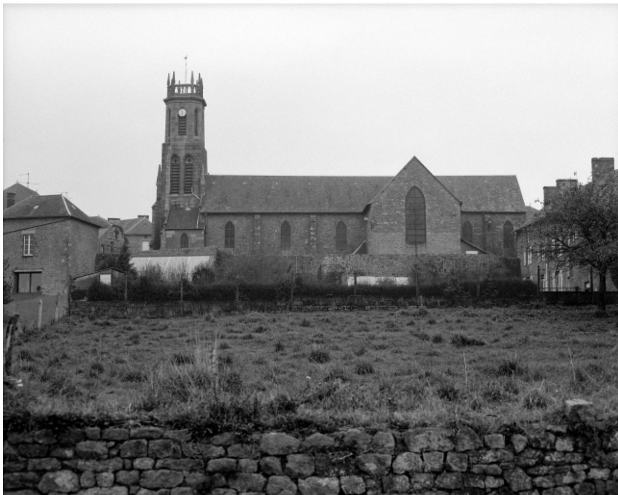
Elévation Sud-Ouest : vue générale
