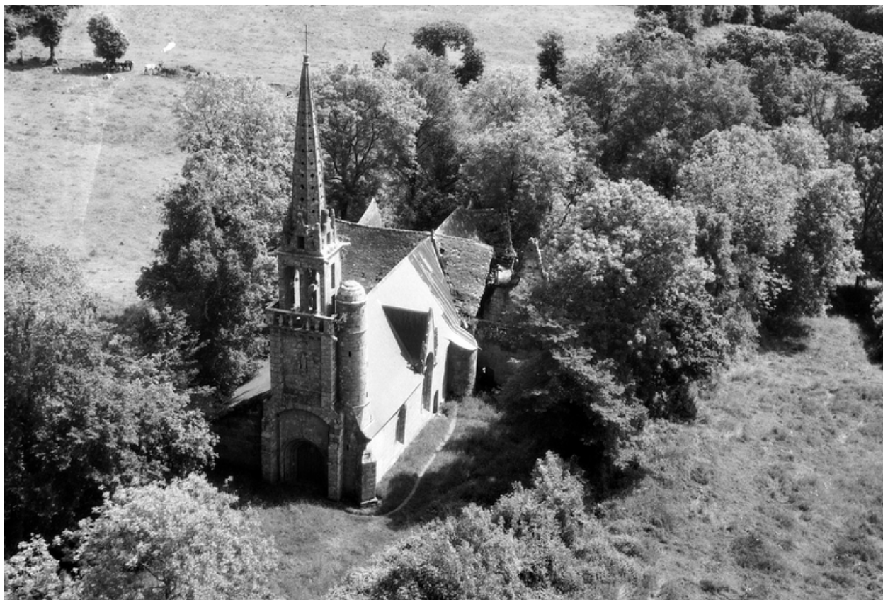
Vue générale prise du sud ouest
