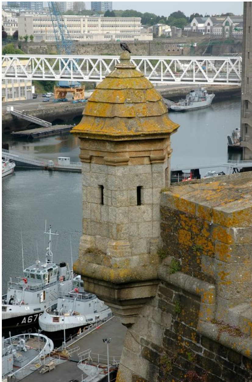
Vue de la guérite/échauguette du bastion de Sourdéac. Au second plan : le pont de Recouvrance
