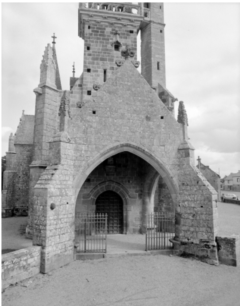
Elévation ouest, porche : vue générale
