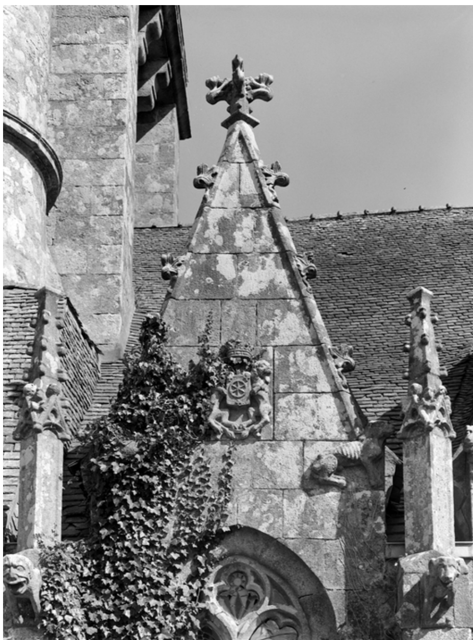
Façade sud : partie ouest, gâble ouest
